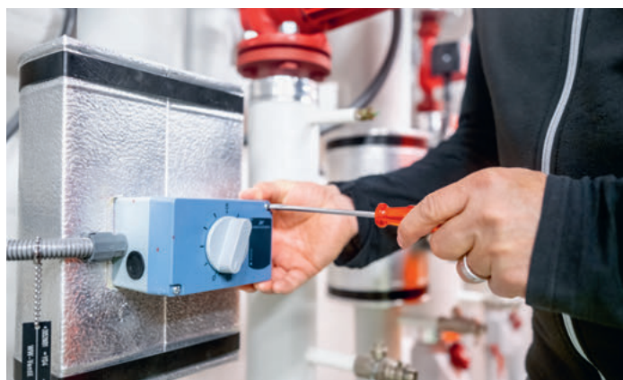
Les laboratoires de METAS sont tributaires d'une climatisation performante.
