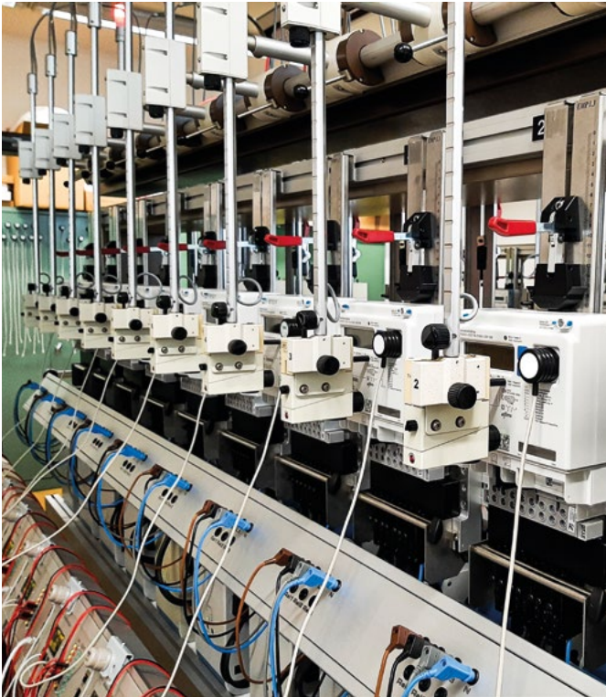
Vérification de compteurs d'électricité.
